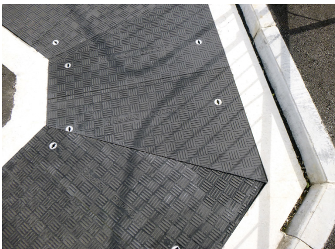
Antypoślizgowa nawierzchnia pokryw Fibrelite usunęła potencjalne ryzyko, które stwarzały pokrywy betonowe w okresach niekorzystnych warunków pogodowych lub wycieków oleju / substancji chemicznych
