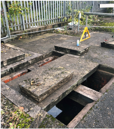
Les plaques en béton précédemment installées présentait des problèmes de manutention
