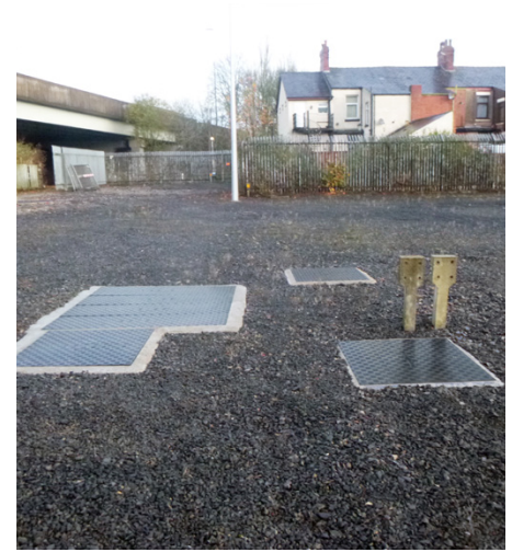
Les plaques d'accès aux tranchées légères de Fibrelite éliminent les risques de manutention antérieurs
