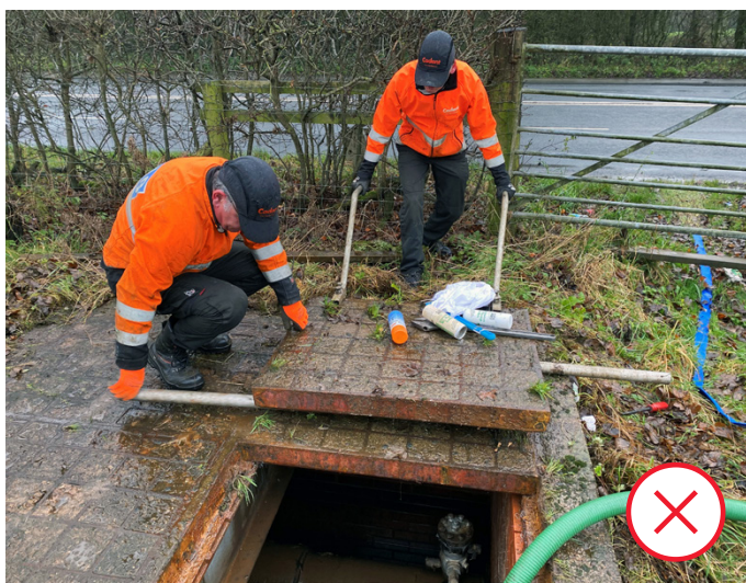
Plaques de tranchée en fonte lourde préalablement installées avec remplissage en béton Plaqués d'accès aux tranchées en PRV légères rénovées de Fibrelite
