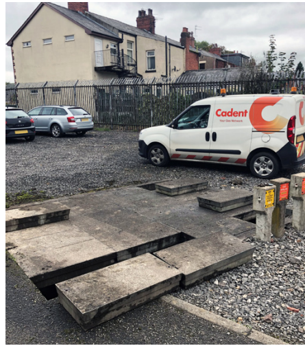
Plaques de tranchée à évitement en fonte lourde précédemment installées avec remplissage en béton
