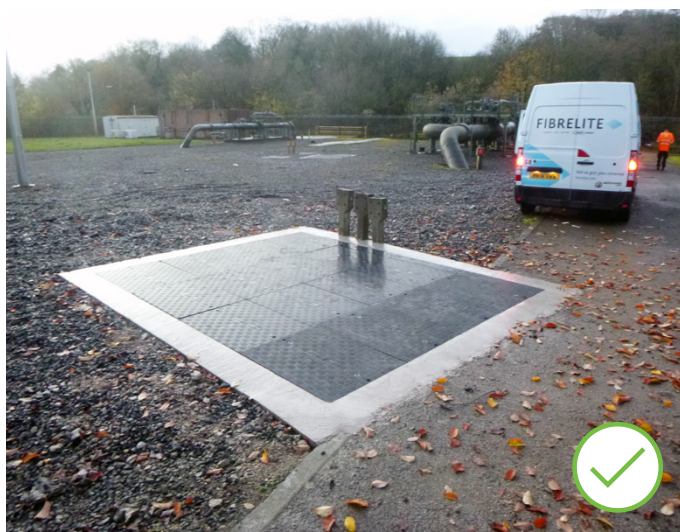
Plaques de tranchée en fonte lourde préalablement installées avec remplissage en béton Plaqués d'accès aux tranchées en PRV légères rénovées de Fibrelite
