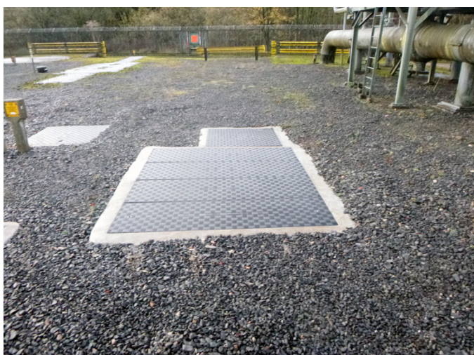
Toutes les plaques d'accès aux tranchées Fibrelite peuvent être facilement retirées et replacées manuellement par deux personnes à l'aide des poignées de levage FL7 ergonomiques de Fibrelite
