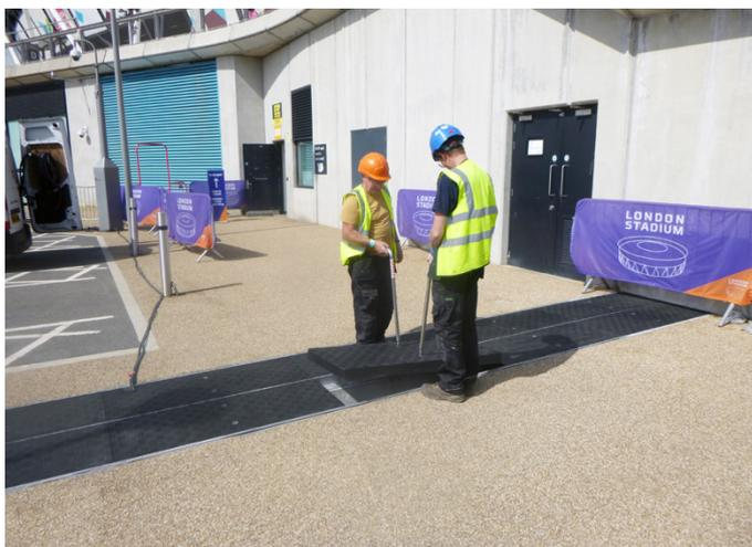
Las tapas Fibrelite pueden ser retiradas fácilmente por dos personas
