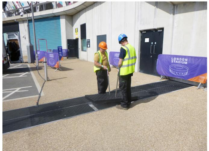
Toutes les plaques de tranchée Fibrelite peuvent être retirées en toute sécurité et rapidement par deux personnes à l'aide des poignées de levage FL7 (image utilisée à des fins d'illustration et montrant une installation différente)
