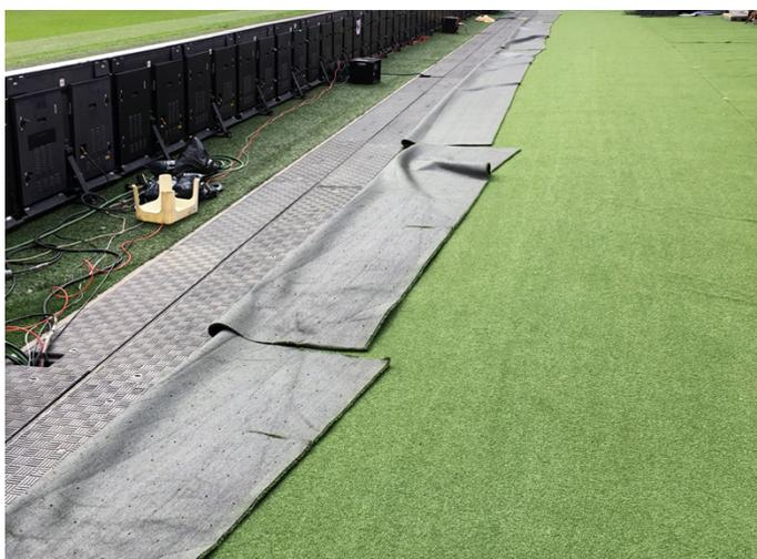
Plaques de tranchée Fibrelite sur mesure installées sur des tranchées de câblage électrique
