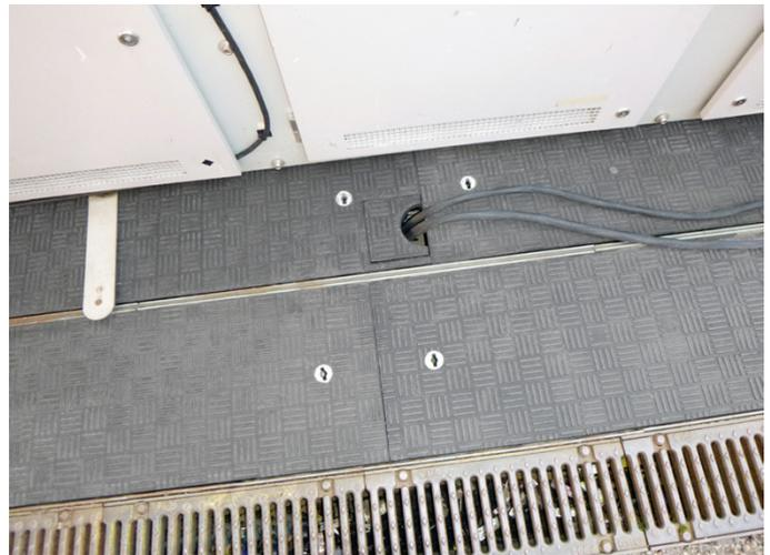
Fibrelite a fourni une solution de rénovation qui pouvait être installée directement dans la structure existante et fournir l'agencement de sortie de câble interchangeable nécessaire sans avoir à modifier les plaques Fibrelite
