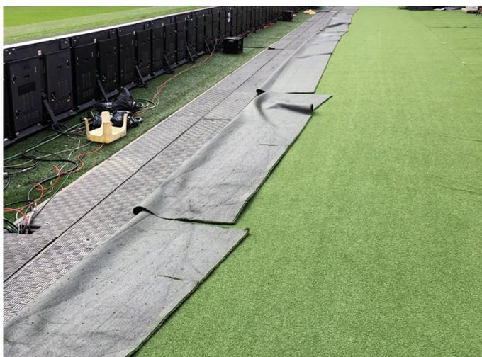
Coberturas (tampas) de valas da Fibrelite em PRFV feitas à medida, instaladas sobre valas de cablagem elétrica
