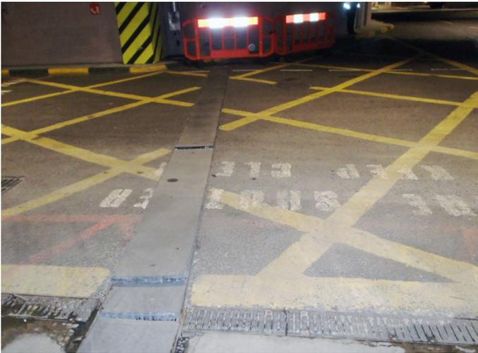
As coberturas anteriormente instaladas estavam mal encaixadas nas suas armações devido ao facto das coberturas estarem distorcidas.
