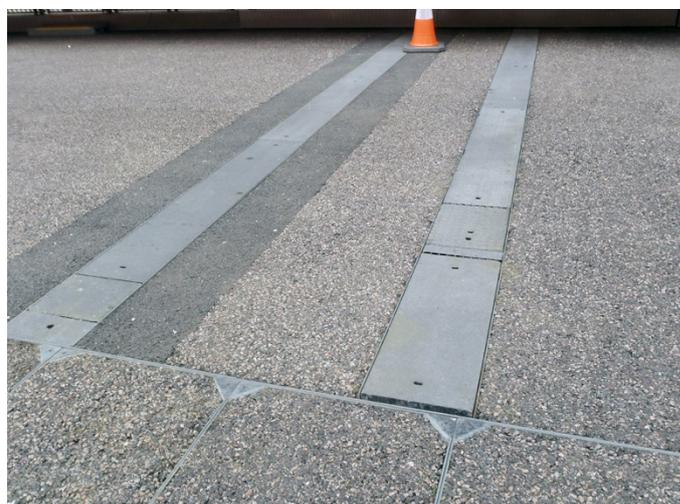
As coberturas anteriormente instaladas não eram capazes de suportar cargas pesadas, provocando fissuras e deformações
