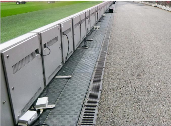
As coberturas (tampas) leves da Fibrelite permitem uma remoção fácil e segura por 2 pessoas
