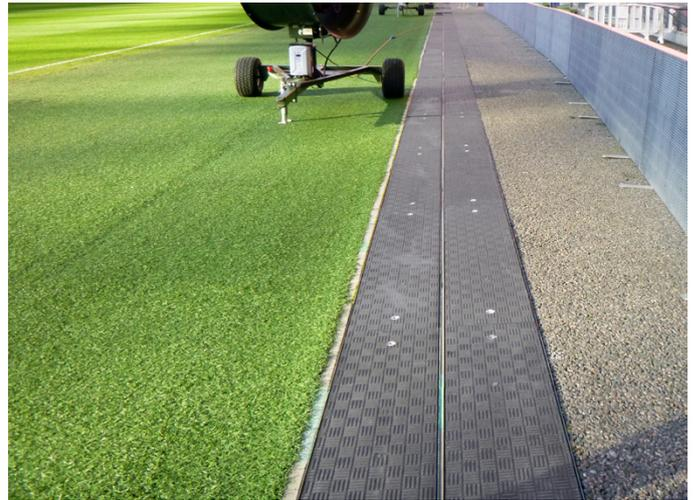
As coberturas (tampas) da Fibrelite têm uma superfície antiderrapante, eficaz quando molhada ou seca
