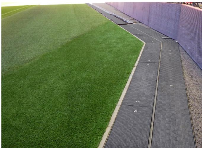
As coberturas (tampas) da Fibrelite proporcionam uma superfície antiderrapante superior, tanto em condições húmidas como secas
