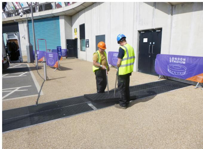
Todas as coberturas (tampas) de valas da Fibrelite podem ser removidas de forma segura e rápida por duas pessoas utilizando as pegas de elevação FL7 (imagem utilizada para fins ilustrativos e mostra uma instalação diferente)
