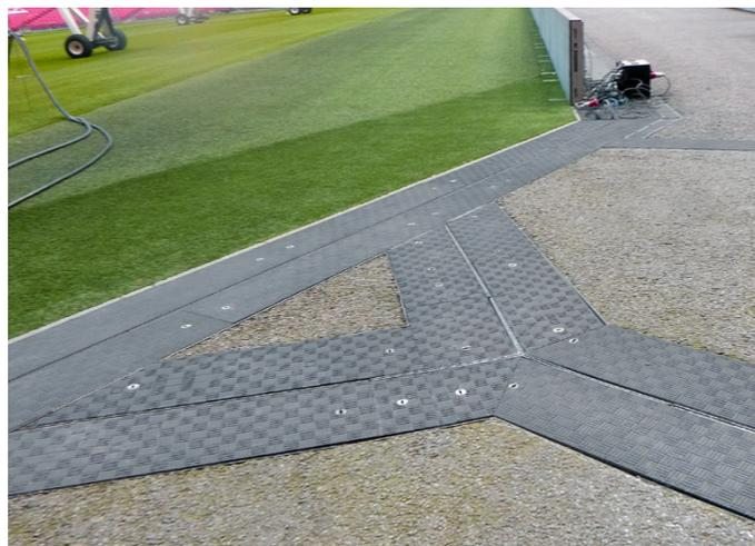
Las tapas Fibrelite al ser químicamente inertes no se oxidan con el paso del tiempo.
