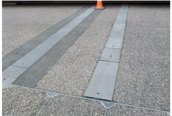
Las tapas antiguas no soportaban cargas pesadas por lo que se deformaban y rompían
