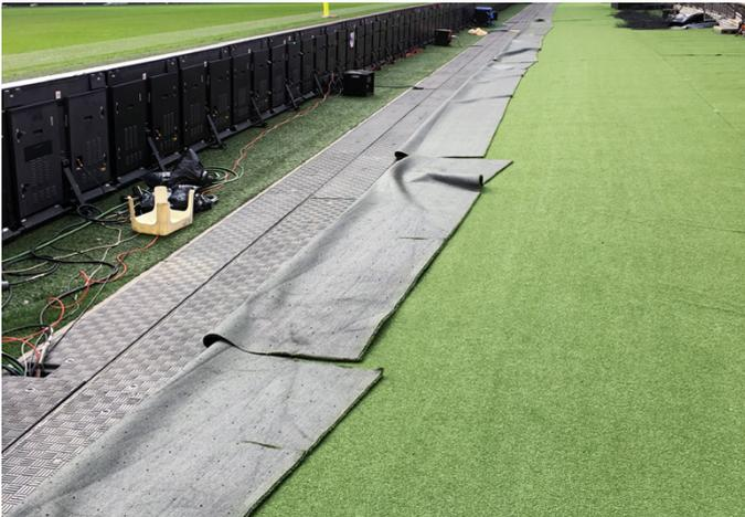
Paneles Fibrelite PRFV hechos a medida sobre la canaleta eléctrica
