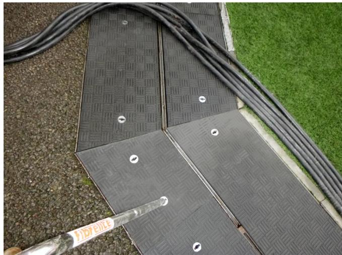
Todas las tapas Fibrelite se abren entre dos personas con el bastón FL7 de manera fácil y segura.
