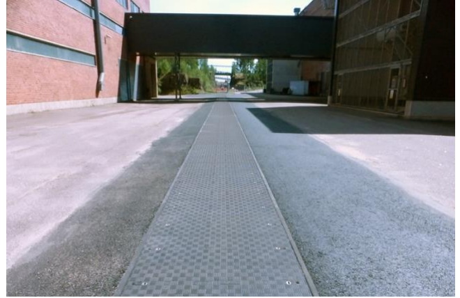
تمديدات من ألواح العزل من شركة فيبرلايت "Fibrelite" طراز FM500-1265-117-D400-2RB تفصل بين صالات الخادم
