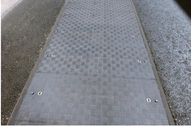
أغطية خنادق بقدرتها تحمل "D400" قادرة على تحمل أقصى ظروف الحركات المرورية. رُعي تعزيز الأمان بإضافة البراغي
