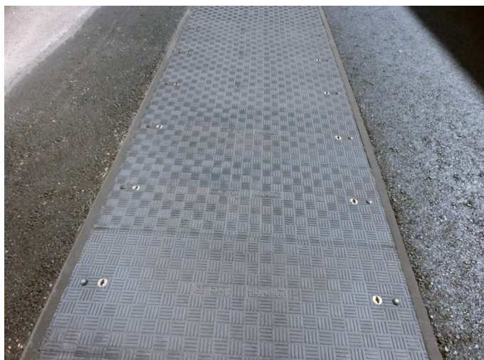
Les plaques de tranchée à charge nominale D400 sont capables de résister à un trafic intense. Des boulons ont été ajoutés pour plus de sécurité
