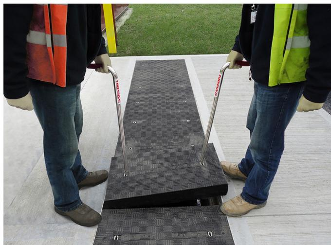
Todas las tapas de zanja Fibrelite pueden ser retiradas con seguridad y rápidamente por dos personas usando las asas de elevación FL7 (la imagen se ha utilizado con fines ilustrativos y muestra una instalación diferente)
