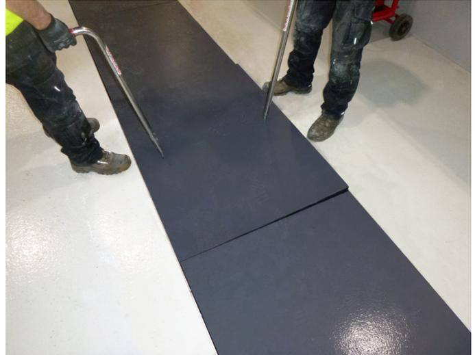
Toutes les plaques de tranchée Fibrelite peuvent être retirées en toute sécurité et rapidement par deux personnes à l'aide des poignées de levage FL7
