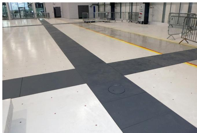
Les plaques de tranchée Fibrelite sont conçues pour être retirés manuellement en toute sécurité
