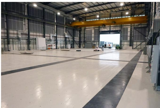
Fibrelite a fourni un agencement de plaques de tranchée composite sur mesure pour ce site de fabrication et de recherche
