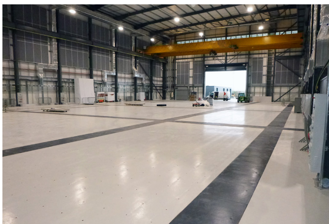
A Fibrelite forneceu um sistema de cobertura de valas em compósito à medida para esta instalação de fabrico e investigação
