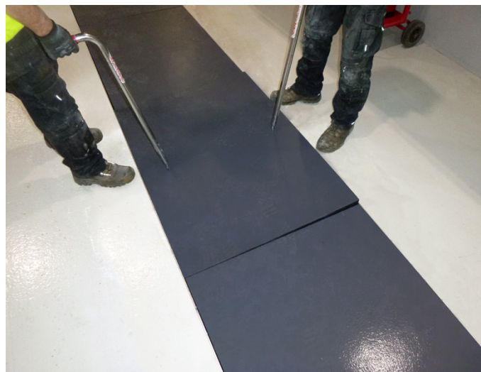
Todas as coberturas de valas Fibrelite podem ser removidas de forma segura e rápida por duas pessoas utilizando os punhos de elevação FL7
