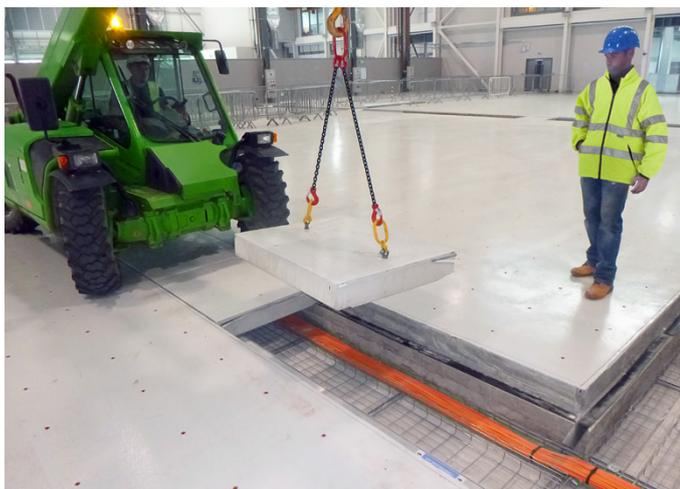
La retirada de las cubiertas previamente existentes era una operación costosa y requería mucho tiempo
