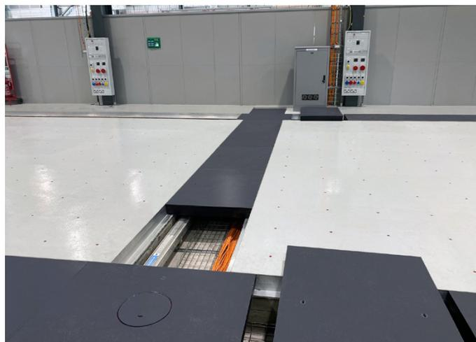
Cubiertas Fibrelite moldeadas sin patrón de dibujo por petición del cliente
