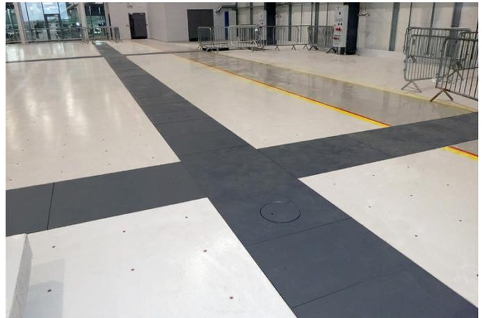
Las cubiertas de zanja Fibrelite se diseñan para ser retiradas manualmente con seguridad
