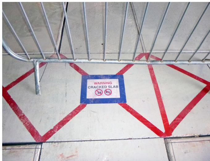
Las cubiertas de hormigón D400 previamente existente estaban agrietadas en algunas
