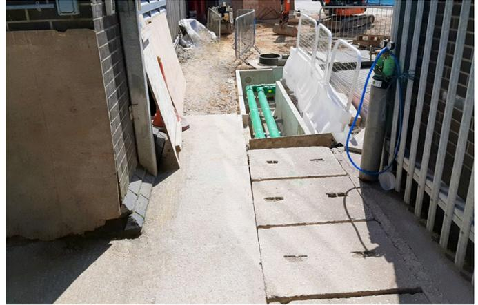
Les plaques d'accès en béton existantes étaient lourdes et difficiles à retirer et à remplacer
