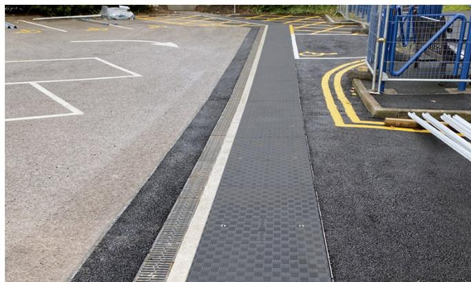
Les plaques Fibrelite sont anti-corrosion, résistent à l'eau, aux gaz souterrains et à la plupart des produits chimiques
