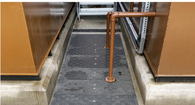
Toutes les plaques de tranchée peuvent être retirées manuellement en toute sécurité par deux personnes tout en étant suffisamment solides pour résister à une charge soutenue
