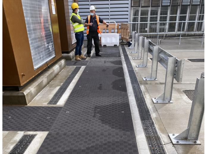
Les plaques Fibrelite éliminent le besoin de personnel spécialisé ou de machines de levage pendant la maintenance ou le fonctionnement
