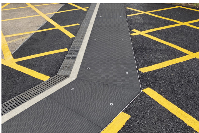
A Hilton Bodill Construction especificou as coberturas Fibrelite e a tubagem KPS para a remodelação do Hospital da Cidade de Nottingham
