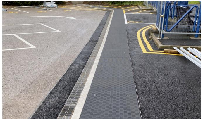
Las cubiertas Fibrelite son resistentes a la corrosión, no se ven afectadas por el agua, gases subterráneos y la mayoría de productos químicos
