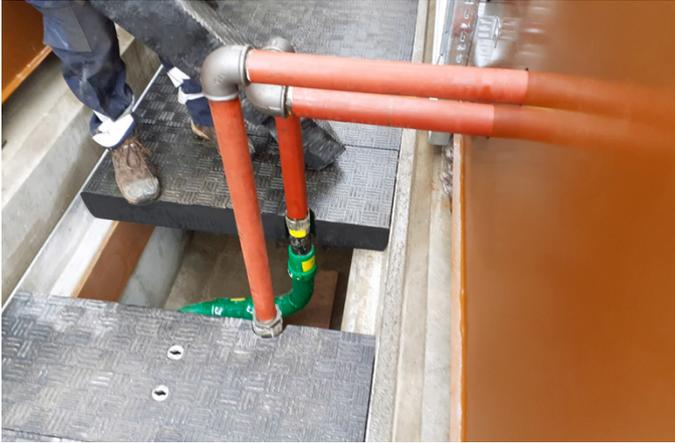
En algunas cubiertas se requerían agujeros para acomodar las tuberías que conectan el interior de la zanja con redes por encima del suelo
