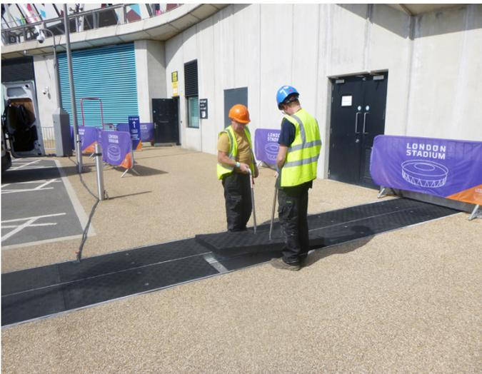
Las cubiertas de zanja de composite Fibrelite se pueden retirar manualmente usando dos asas de elevación FL7 de Fibrelite (como se ve en la imagen anterior en otro emplazamiento)
