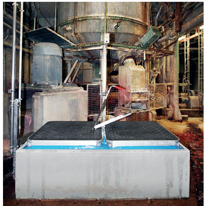
Fertig angebrachte Faserverbundabdeckungen
