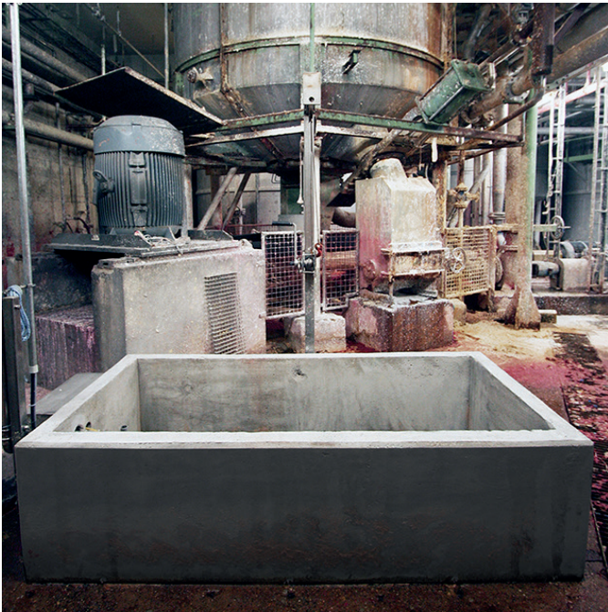
Grundwassersammler muss tagwasserdicht abgedeckt werden
