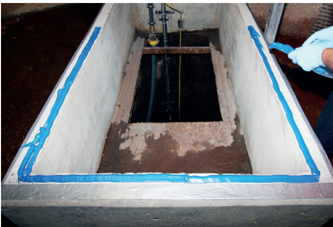
Der Epoxidkleber FlexyPox wird auf den Betonsockel aufgetragen.
