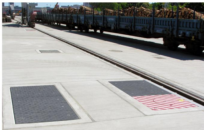
As coberturas Fibrelite foram concebidas e fabricadas à medida para encaixar diretamente nas aberturas existentes, minimizando o tempo de instalação
