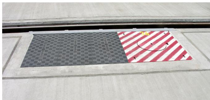
Todas as coberturas de valas Fibrelite podem ser removidas e substituídas em segurança por duas pessoas utilizando as pegas de elevação FL7 devido à sua elevada relação resistência/peso
