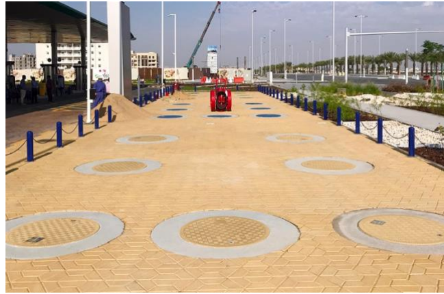
تزن أغطية غرف تفتيش فيبرلايت "Fibrelite" المصنوعة من اللدائن المدعومة بألياف صناعية "GRP" ثلث وزن الأغطية المعدنية ذات الحجم المكافئ.
