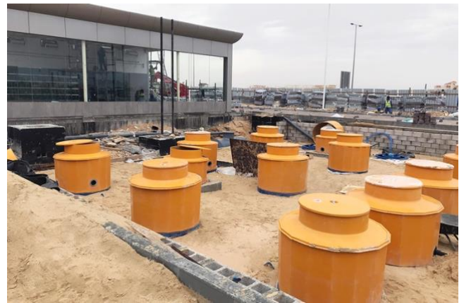
توفر أحواض فيبرلايت "Fibrelite" القابلة للاختبار والمصنوعة من اللدائن المدعومة بألياف صناعية "GRP" حلاً قويًا ودائمًا لاحتواء السوائل بشكل فعال
