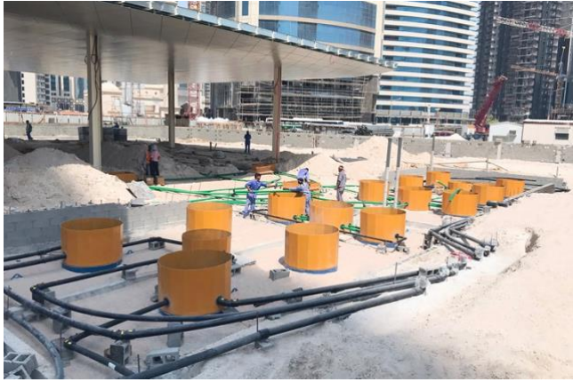
تتطلب وصلات اللحام الكهربائي المدمجة لأنابيب KPS أقل وقت لحام ممكن
