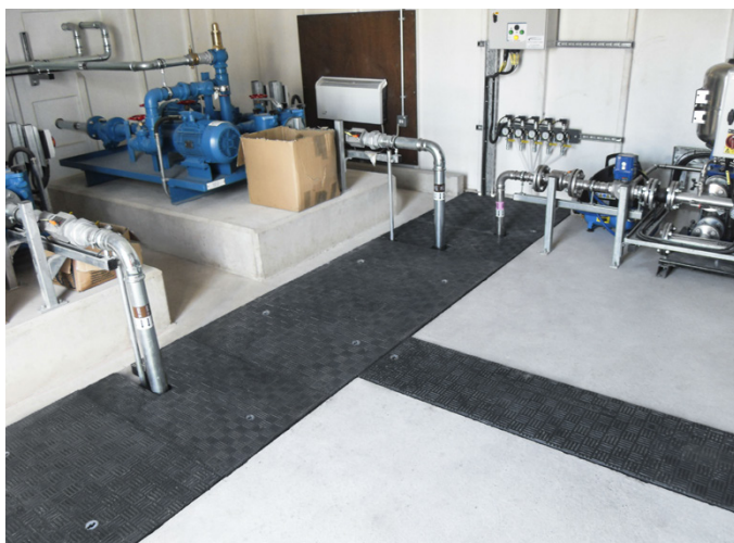
Zamontowano pokrywy o dwóch różnych klasach obciążeń, B125 i D400
