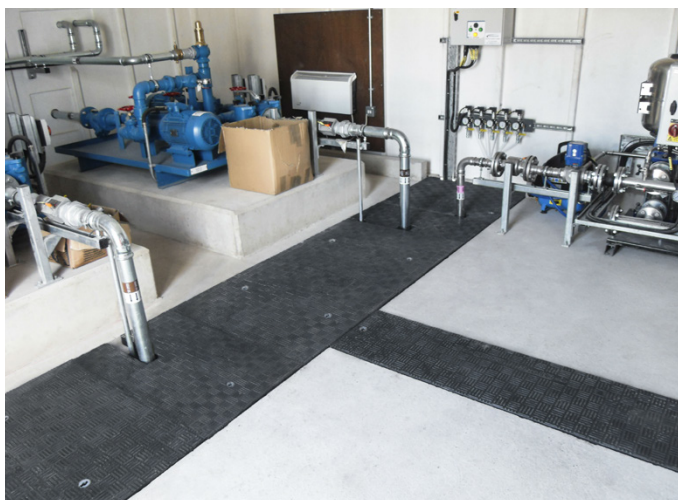
Zamontowano pokrywy o dwóch różnych klasach obciążenia, B125 i D400
