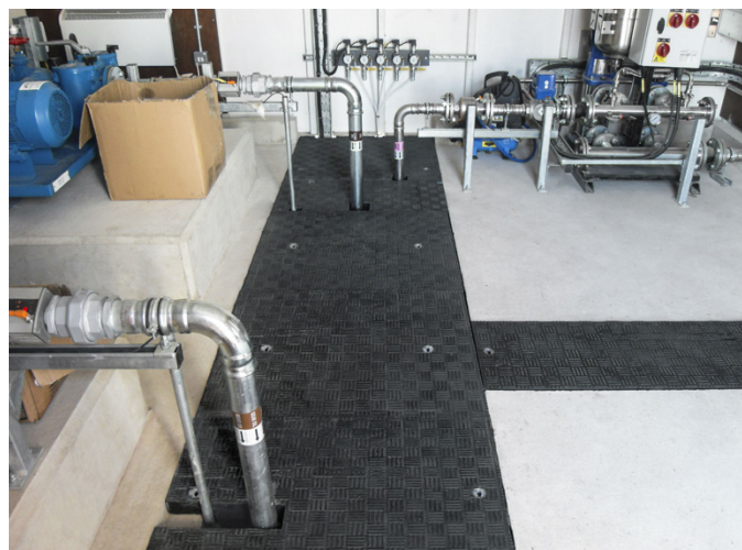
Przez pokrywy Fibrelite mogą przechodzić rury o różnych rozmiarach i kształtach
