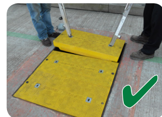
Bezpečné a rychlé manuální zvedání pomocí zvedacích pák Fibrelite
