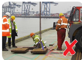
Těžké desky z korodující oceli vyžadující jeřáb a náležité zvedací zařízení
