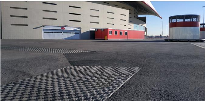
Le coperture ispezionabili Fibrelite forniscono una superficie di calpestio sicura grazie al disegno unico della loro superficie
