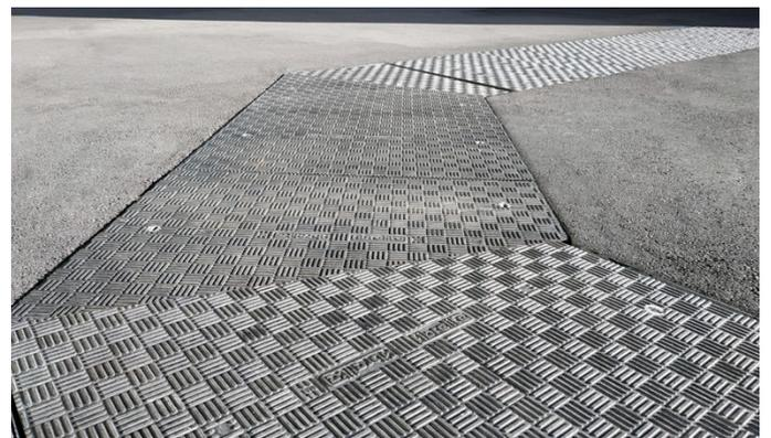
Fibrelite ha fornito un sistema su misura di coperture per canali in materiale composito leggero e modulare
