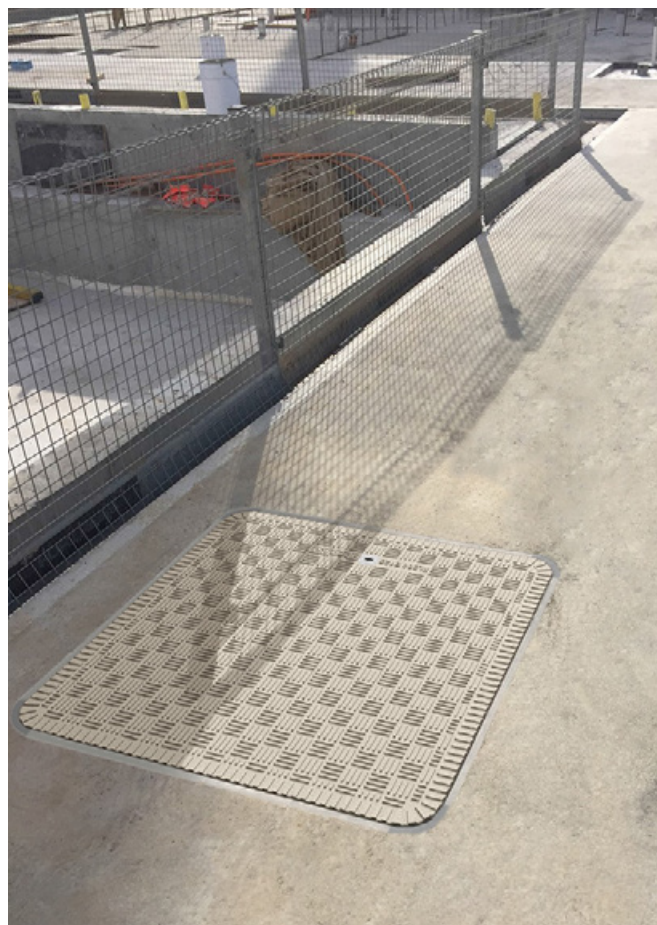
Eingebaute Abdeckung über Ausgleichtanks
