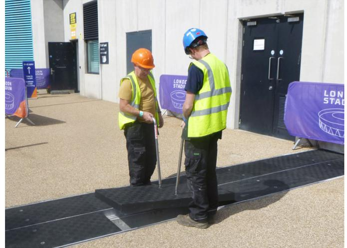
Les plaques de tranchée FRP légères de Fibrelite peuvent être retirées en toute sécurité et rapidement par 2 personnes (image utilisée à des fins d'illustration et montrant une installation différente)
