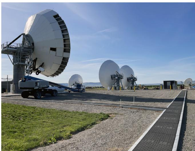
Le système de tranchée et de plaques Fibrelite Trenwa installé dans un site de satellite critique
