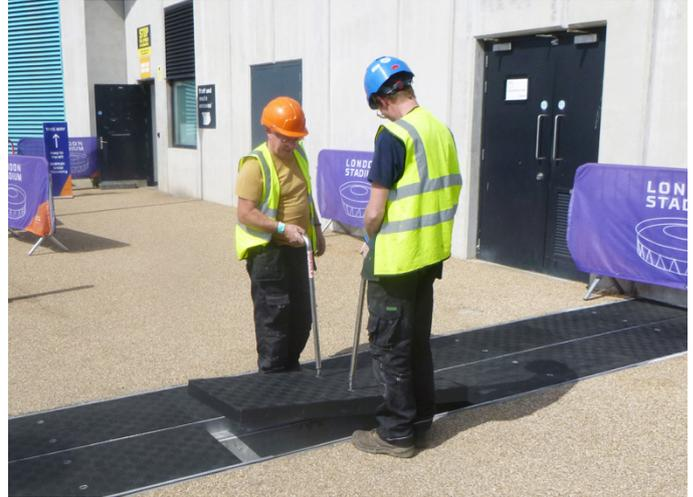
Las cubiertas de zanja FRP ligeras de Fibrelite pueden ser retiradas con seguridad y rápidamente por 2 personas (la imagen se usa como ilustración y muestra una instalación diferente)
