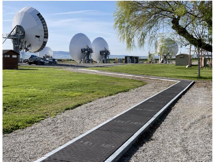
El sistema de zanja y cubierta Fibrelite Trenwa protege y permite un acceso seguro y rápido a cables que discurren desde las antenas a las salas de control
